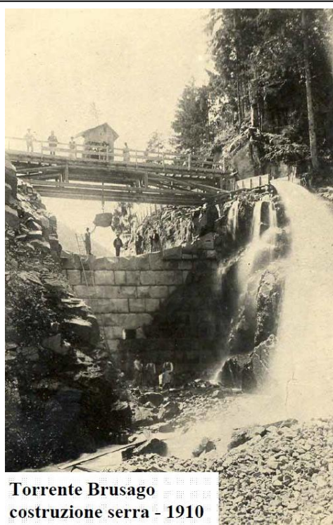
Fig. 3.18-3.19 – La grande “serra” realizzata nel 1910 in pietrame con grossi massi lavorati sul posto, ancora perfettamente conservata (foto Archivio Servizio Bacini montani).
