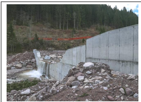
Fig. 3.20-3.22 - Recente sistemazione del tratto medio del rio Brusago con opere trasversali di consolidamento in cls armato a doppia gàveta.
