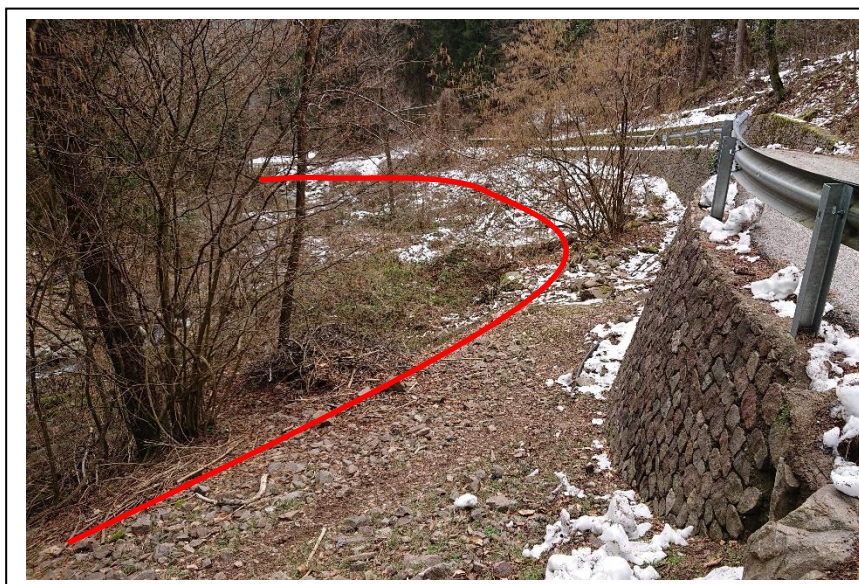
Fig. 3.47 – Tratto del rio del Molino ove realizzare un'eventuale protezione al piede del muro di sostegno della strada.
